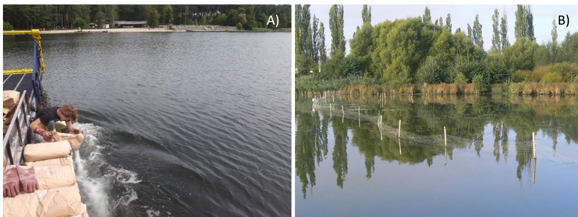
Obrázek 2: A) Aplikace srážení rozpuštěného fosforu a B) kultivace vodní vegetace v ohrádce během revitalizace Velkého Boleveckého rybníka (autor: J. Duras).
