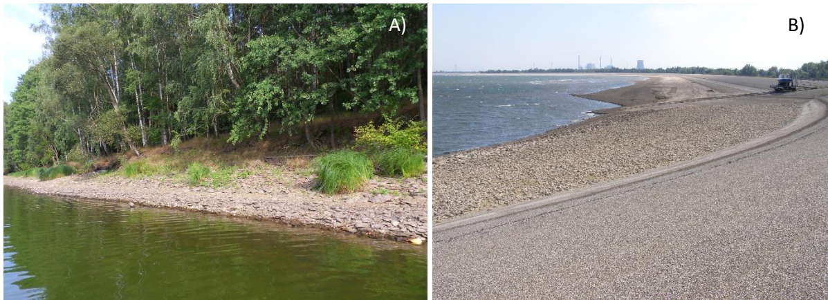
Obrázek 4: Příklady degradovaného litorálu vlivem kolísání hladiny na A) nádrži Žlutice a B) umělém jezeře De Gijster.
