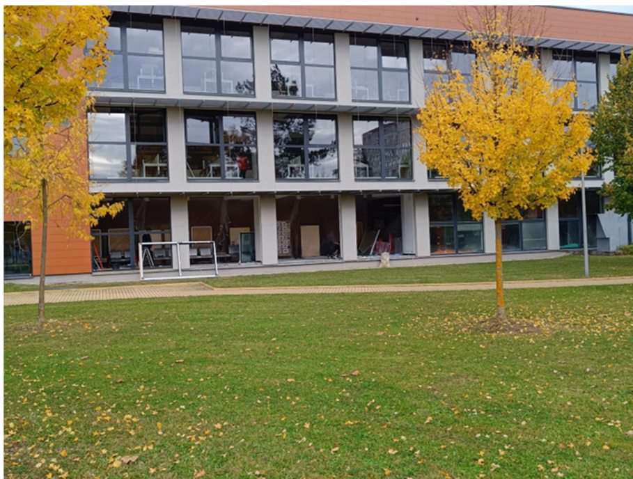
Probíhající práce na výměně oken, budova Akademické knihovny JU. Foto: Projektový útvar JU.
