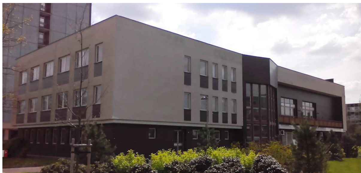
Stávající stav budovy univerzitní auly Bobík. Foto: Václav Lukeš.
